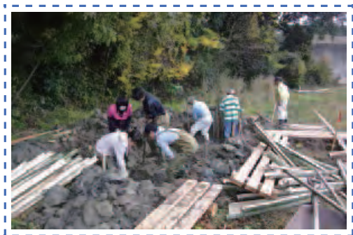
池掘り，砂入れ，木道整備，竹柵設置
