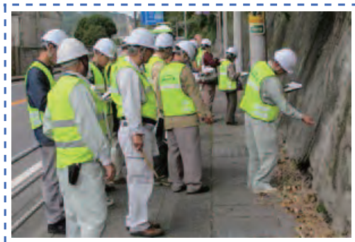
道路斜面の亀裂箇所等を観察
