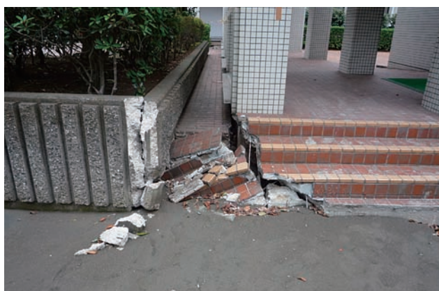
千葉学習センターエントランス
